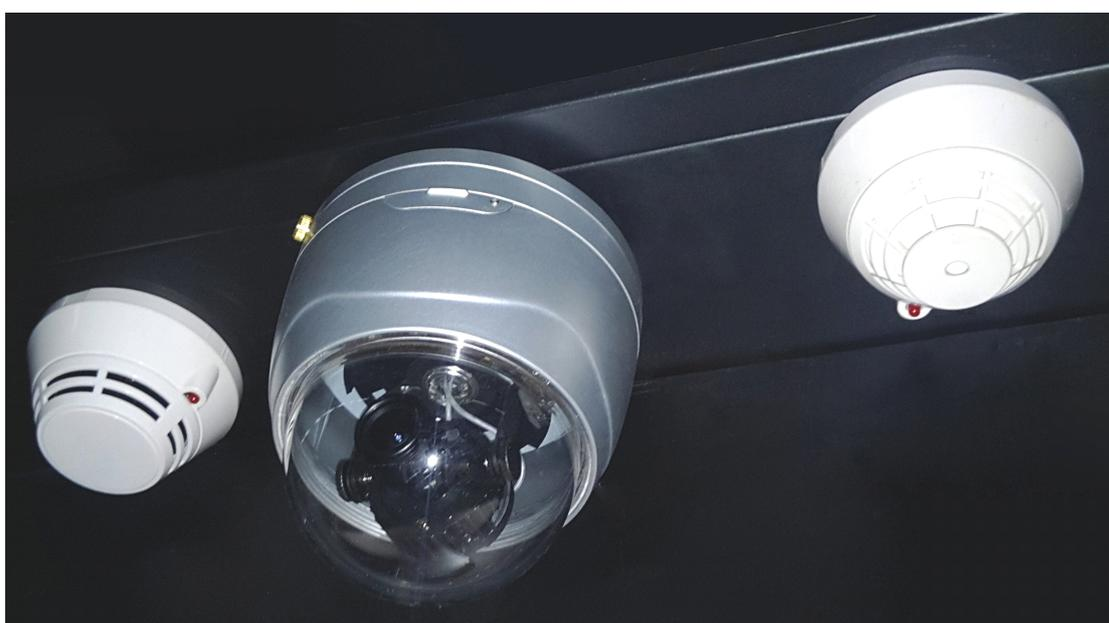
图 41 冷通道内摄像头、温度传感器、烟雾传感器安装实物图
